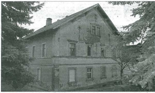
Dieses alte und historische Schulhaus neben der Kirche gehört zum Mittelpunkt von Rügheim. Nun soll es saniert und von den Rügheimer Vereinen genutzt werden.
